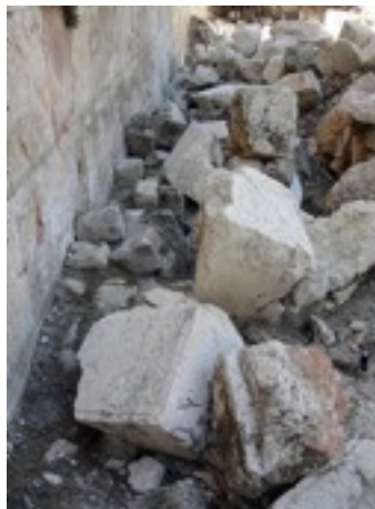
Von römischen Soldaten im Jahr 70 n. Chr. aus der Westmauer des Tempelberges herausgerissene Steine Foto: Wikipedia
